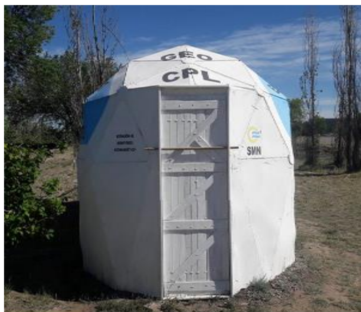
Figura 4: Casilla Geomagnética de la Estación CIP
