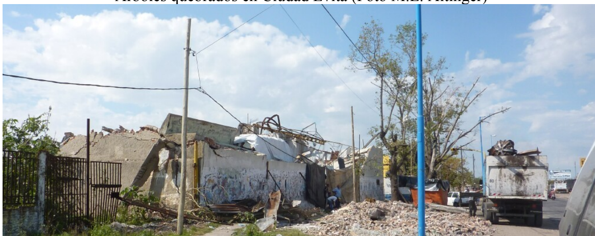
Edificio destruido en Quilmes Oeste (Foto M.L. Altinger)
