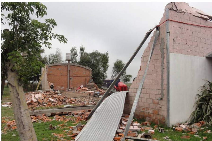
Galpón destruido, 7 km al sur de General Rodríguez, en el camino a Navarro. (Foto L. Rosso)
