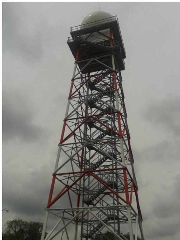
**Figura 4.** Vista de la torre y radomo del radar RMA2 instalado en el marco del proyecto SINARAME en el predio del Instituto Nacional del Agua en cercanías del Aeropuerto Internacional de Ezeiza (Créditos: Luciano Vidal)
