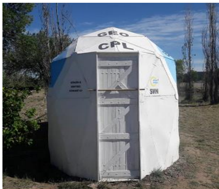
Figura 4: Casilla Geomagnética de la Estación CIP
