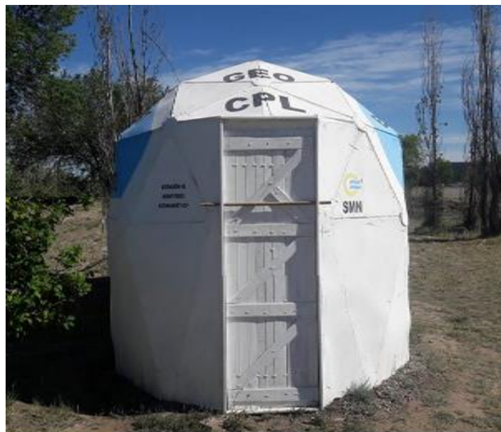
Figura 4: Casilla Geomagnética de la Estación CIP
