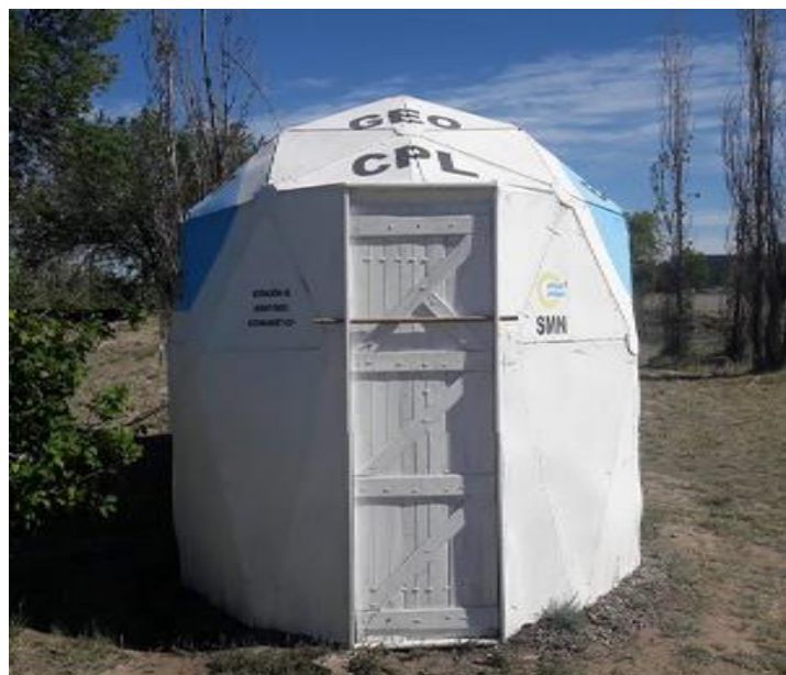
Figura 4: Casilla Geomagnética de la Estación CIP
