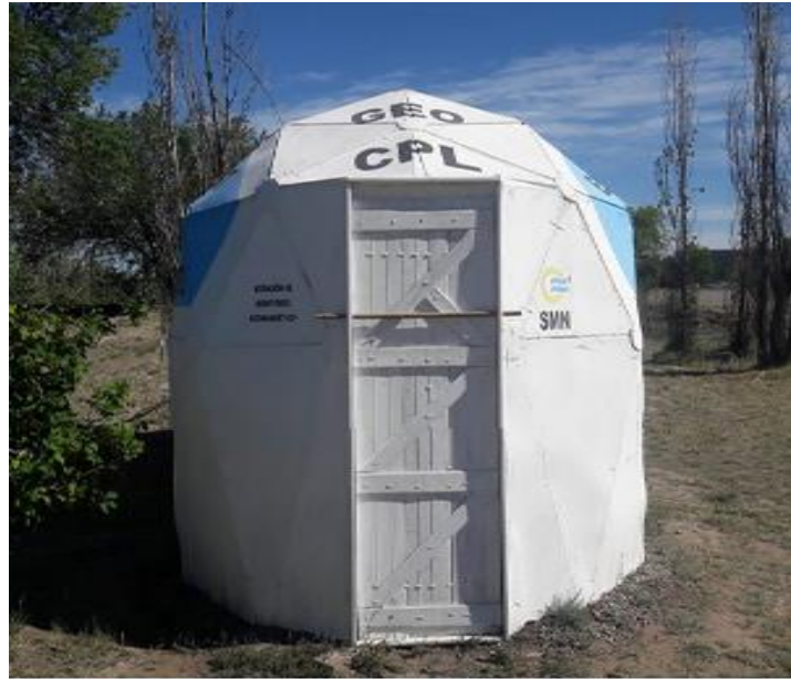
Figura 4: Casilla Geomagnética de la Estación CIP
