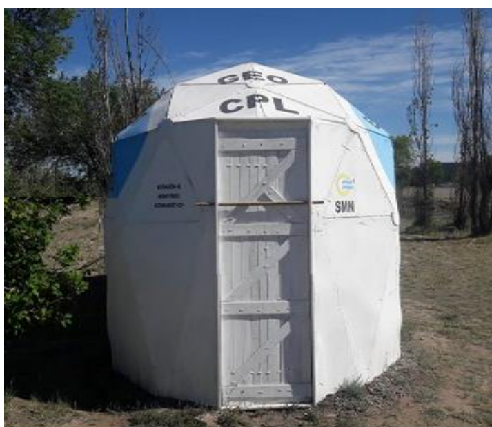
Figura 4: Casilla Geomagnética de la Estación CIP
